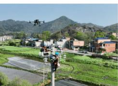
“无人机+架网隔离法”作业是基于无人机组成的跨线、跨路线路不停电架线施工方法。当天，在上栗县的楚山变电站110千伏线路新建工程现场，地面作业人员通过操作无人机携带牵引线，与高空作业人员配合，完成涉及附近1万余户居民的三条110kV线路带电跨越放线作业。跨越宽度达到61米，属于超长跨越。按照传统的施工方式，需要大部分地区配合停电才能进行作业，这对于居民用电以及周边企
